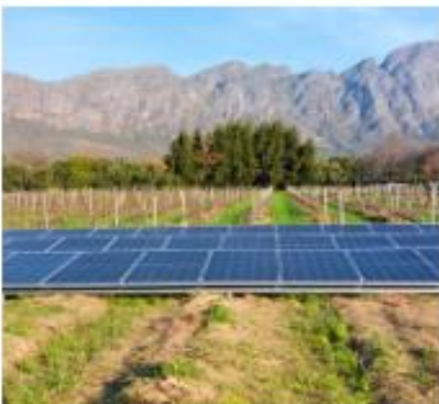
KLEIN CHAMPANGE, FRANSCHOEK 28.6kWp, 48kW Sunsynk & 100kWh Revov Lithium 2023
